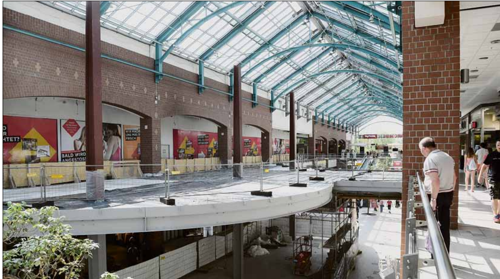
Die Brücke, auf der die Food Lounge künftig zum Schlemmen einlädt, nimmt Gestalt an.
