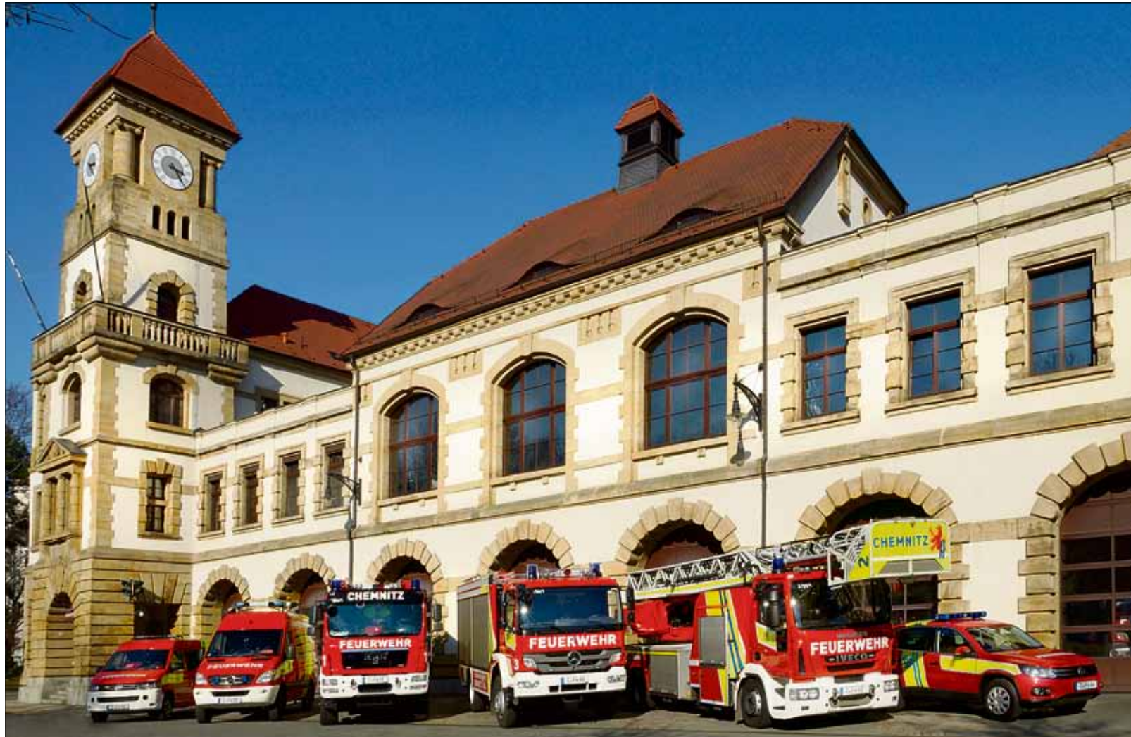
Das Gebäude an der Schadestraße ist seit 1906 als Feuerwache in Betrieb. Von hier aus koordiniert die Leitstelle die bei einem Notfall zu treffenden Maßnahmen. Foto: Berufsfeuerwehr Chemnitz
